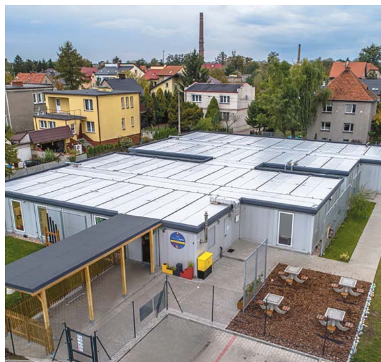
Modułowa konstrukcja przedszkola Marco Polo przy ul. Zatorskiej – w takiej technologii zostanie zbudowana szkoła przy ul. Lubelskiej
