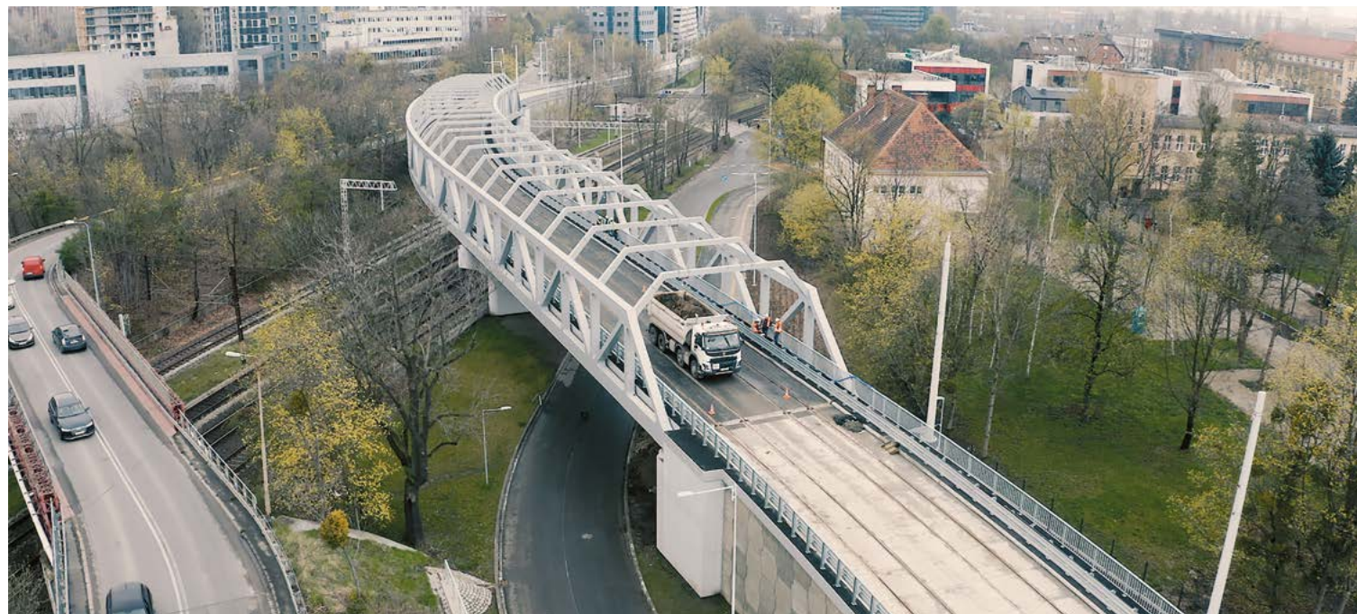
Wiadukt nad torami i ul. Robotniczą ma skomplikowaną i nietypową konstrukcję, dlatego próby obciążeniowe tego obiektu były tak ważne
